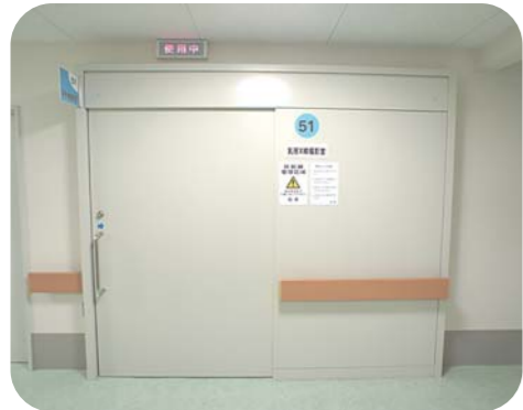
乳房撮影専用室
